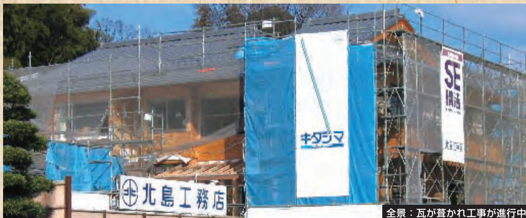
全景：瓦が葺かれ工事が進行中
