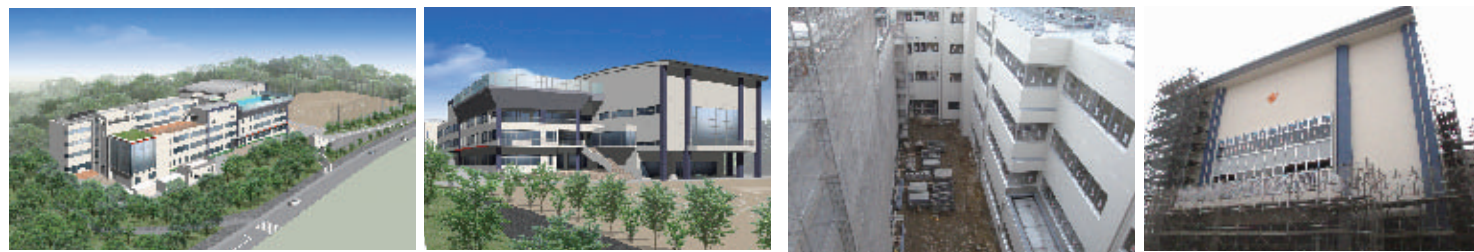
完成予想図(全景) 完成予想図(体育館棟) 姿を現した教室棟 一部足場の取れた体育館棟
