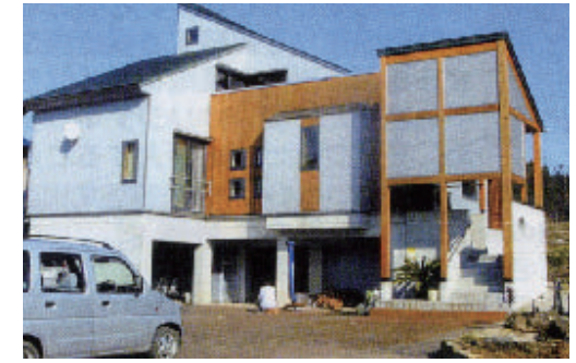
地震直後のG邸。大きな損傷は見られない。
