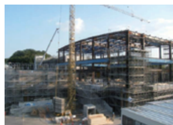
工事中の柿生中学校
