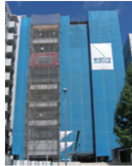
最上階までコンクリート打設終了
