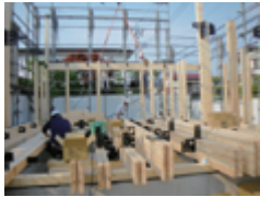
現場の骨組み
