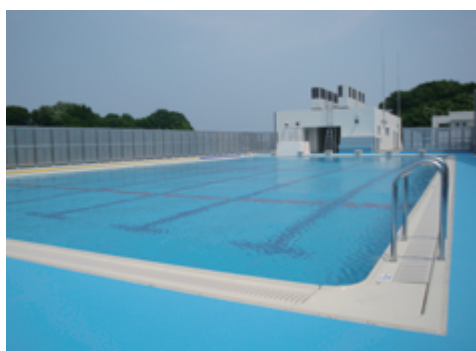
屋上に25mプールを新設
