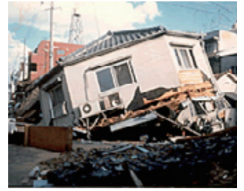
地震による住宅倒壊
