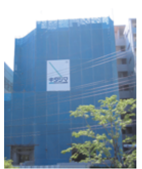
エントランス面の状況
