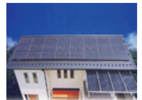
太陽光パネル
