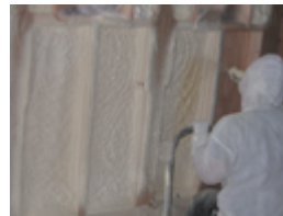
断熱材の吹付け作業
