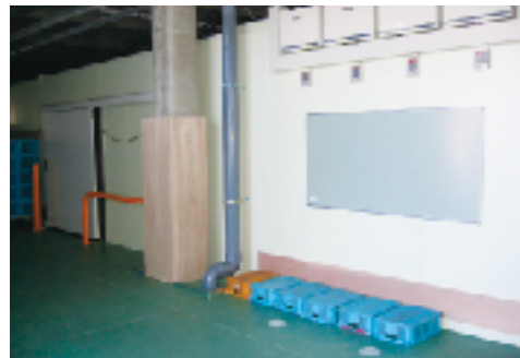
麻生センターの心臓部・冷凍冷蔵庫
