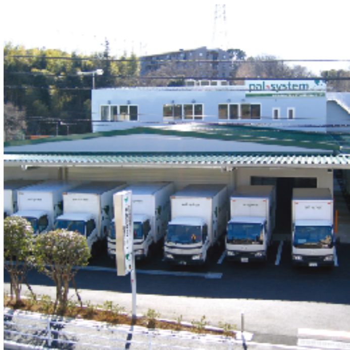
神奈川ゆめコープ：平成23年2月竣工（施工：北島工務店）
