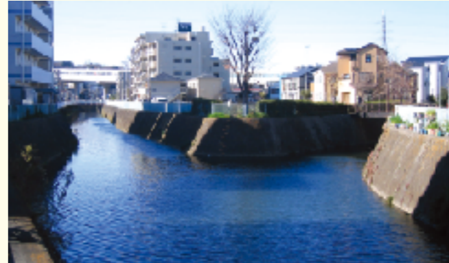
P 久地の合流地点 JR南武線久地駅の近く。中野島と宿河原で取水した多摩川の水はここで合流し、稲毛・川崎を潤してきた。昭和9年から57年までの許可水量は中野島が45万トン、宿河原が約35万トンで、一日当たり約80万トンとなっていた。
