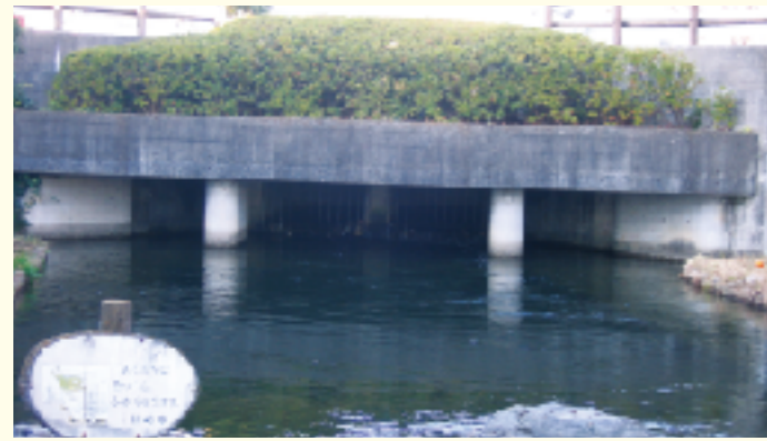
B 二ヶ領の覆水・新三沢川との合流地点 二ヶ領用水は新三沢川の下に用水をU字状に掘り抜き、用水の上流より下流の水面を少し低くすることで、気圧の関係でこのU字溝を水がどんどん通過する。(サイフォンの原理)
