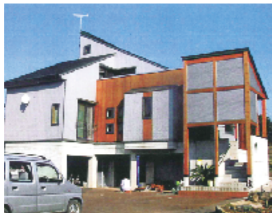
地震直後のG邸。大きな損傷は見られない。
