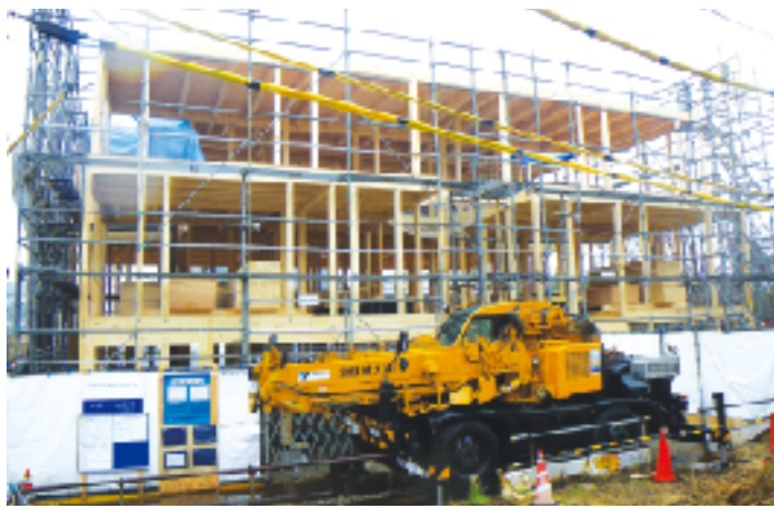
新築中の3階建て共同住宅
