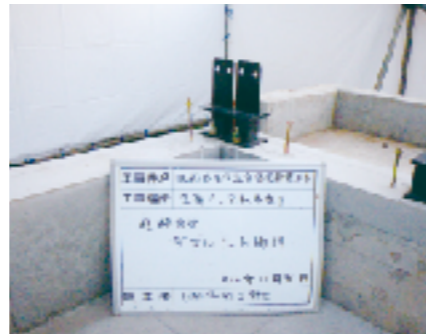
基礎に直接アンカーされた柱脚金物
