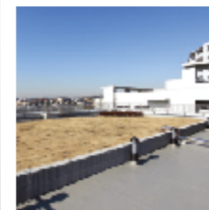
屋上緑化をしました
