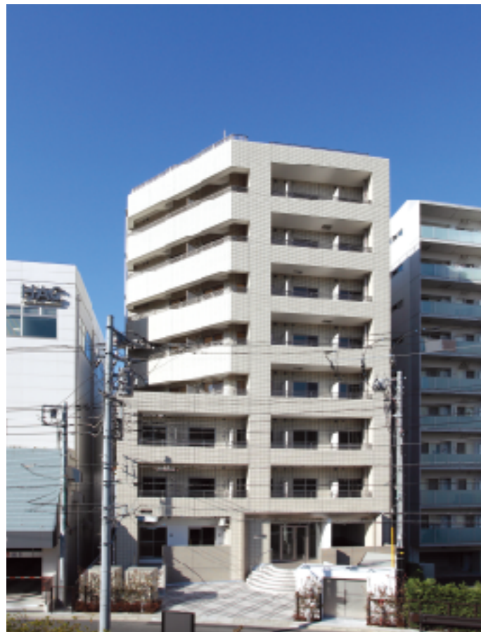
外観東面全景
