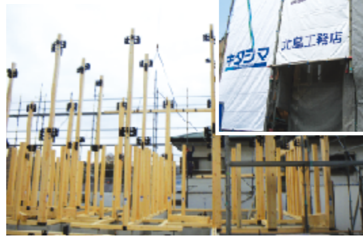
組み立て中の柱とSE金物
