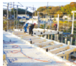
梁の組み立て
