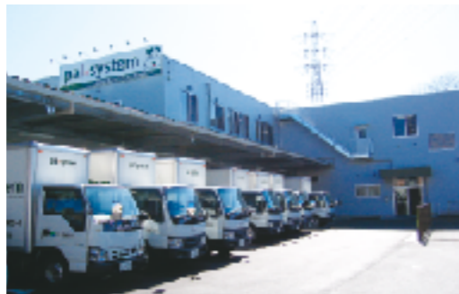
正面玄関付近
