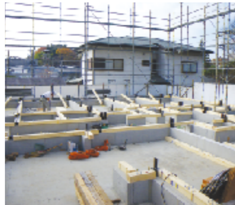
震度7の激震に耐えられる高耐震基礎とSE金物の土台
