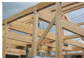
骨組みが完成しました
