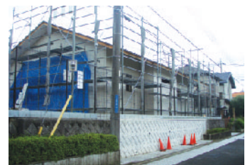
屋根・外壁ができ完成間近です
