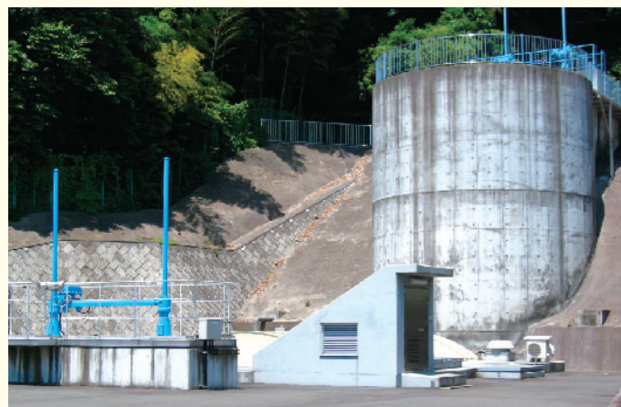
D 神奈川県営柿生発電所 昭和37年8月11日に運転開始された、水を運ぶ隧道(ずいどう)管は川崎市で管理され、発電設備は神奈川県で管理されている。この施設は川崎市水道導水路の途中にある、約12mの遊休落差を利用した環境に優しい水力発電所。発電した電力量は、一般家庭約1,350軒分の年間消費量に相当するほか、石油火力で同量の発電をした場合と比較し約3,600トンのCO2(二酸化炭素)削減効果があり、この削減量は約160haの森林(生田緑地の1.4倍の面積)が吸収するCO2量に相当する。 最大出力:680Kw 年間発電量:4,865千Kwh
