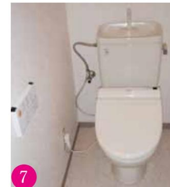
7 シャワー便座取付完了。※シャワー便座には専用電源が必要になります。※リモコンは電池式となっていますので動作が悪くなら電池を交換しましょう。※取付には専用工具が必要となります。
