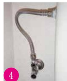
4 分岐バルブを取付けます※ロータンク用給水管の切詰めの場合もあります。
