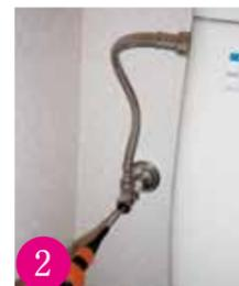
2 止水バルブ(メーターバルブ)を閉めて水を止めます。
