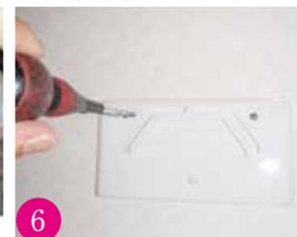
6 壁面にボードアンカーを埋込みリモコン受けを取付ビスにて設置します。
