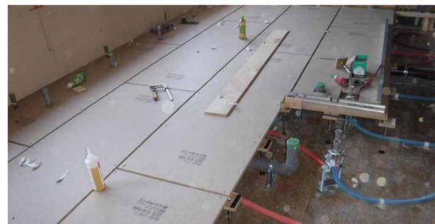
③ 配管設備の上に床面設置します
