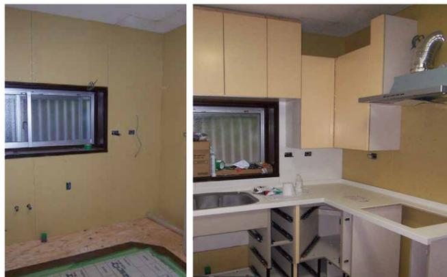
下地工事完了、流し台設置開始
