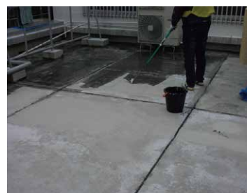
【工程2】防水面清掃完了後に プライマー（接着剤）を 塗布します。
