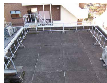
【Before】既存現況状態） アスファルト防水の上、 押えコンクリート仕上
