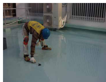
【工程10】平場ウレタン塗膜防水 塗布状況（2層目）
