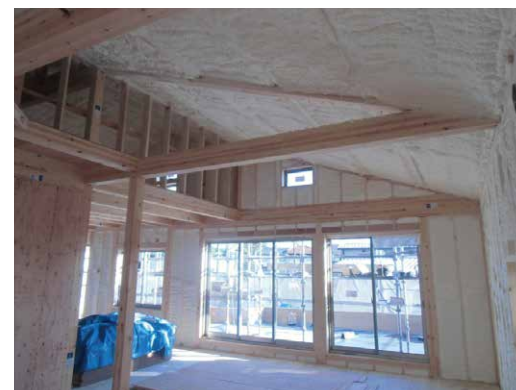
▲断熱材吹付状況
