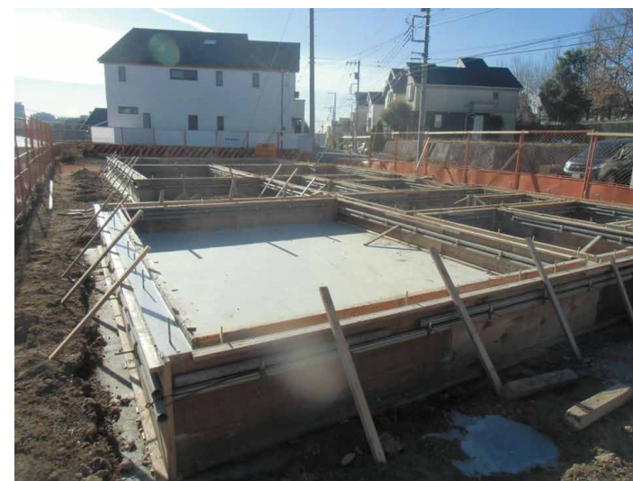
▲基礎コンクリート打設
