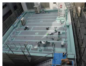
【工程8】通気緩衝シートの ジョイント処理及び 立上り部補強完了状況
