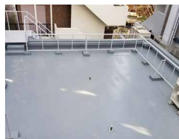
【After】改修完了状況） ウレタン塗膜防水 通気緩衝工法
