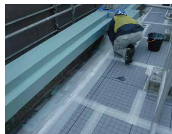
【工程6】防水層の立上り部に メッシュシートを貼り 補強します。
