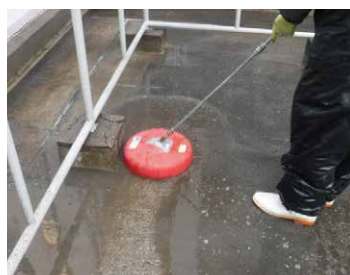
【工程1】現況の押えコンクリート面を 高圧水洗浄により 新規防水面の清掃をします。
