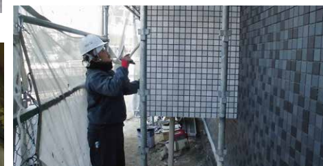
▲外壁タイル貼り状況
