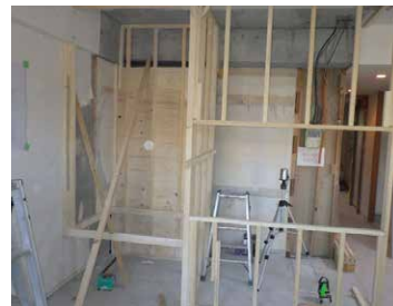
【工程3】 新規間仕切組立
