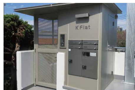
▲オートロック化したエントランス
