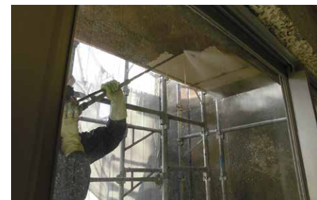
▲既存塗膜除去状況
