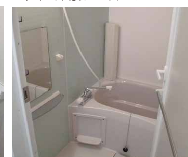
3点式から別々に改修したユニットバス・トイレ・洗面化粧台
