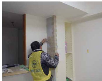
【工程6】 リビングエコカラット貼 (アクセント・調湿)
