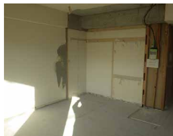
【工程2】 解体完了
