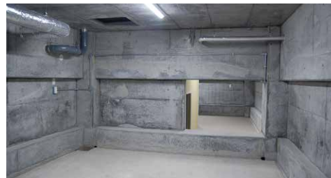
▲地階全て使用した大空間の倉庫
