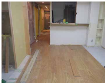
【工程5】 床フローリング貼
