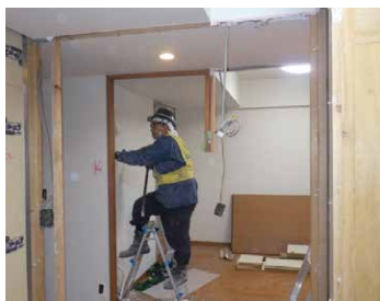
【工程1】 既存解体 必要な間仕切を残して解体します。
