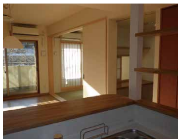
【After】 リビング隣の洋室の壁を取り外し3枚引き込み戸にして開放的な和室になりました。
