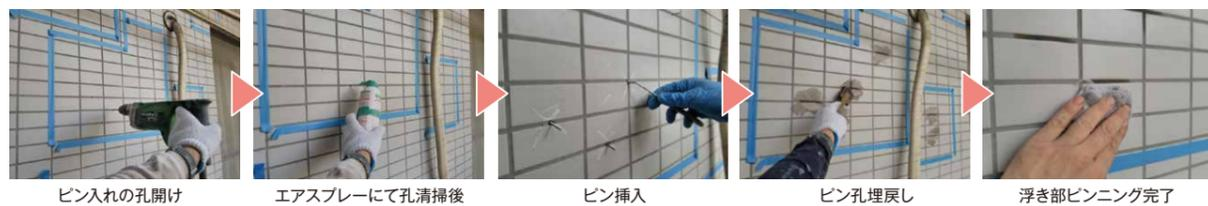
②外壁タイルひび割れ補修：ひび割れたタイルを撤去し、新たに焼いたタイルを張戻します。既存と同系色のタイル焼きに約3ヶ月の工程が必要になります。類似品の市販品の場合は2週間で納品となります。
