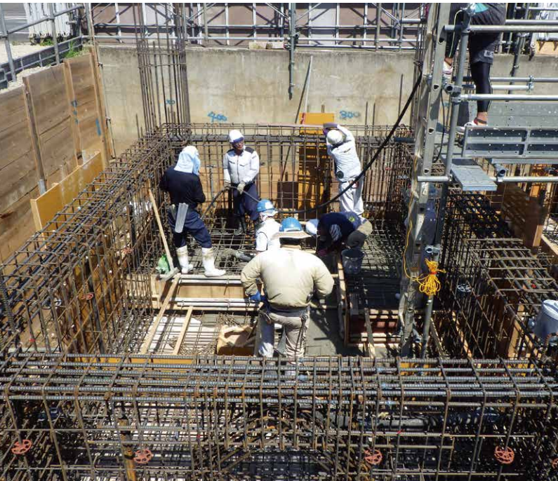
基礎躯体工事
