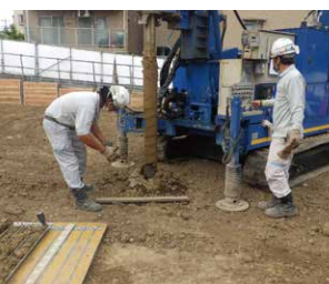
地盤改良杭工事
