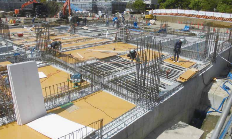
基礎部躯体工事
