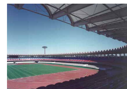
等々力競技場増築工事 (平成7年撮影)
