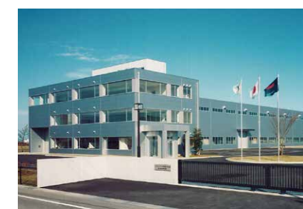
アイダエンジニアリング(株)松任工場新築工事 (平成7年撮影)
