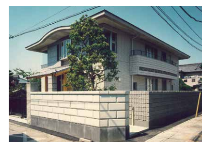
明王院客殿新築工事 (平成7年撮影)
