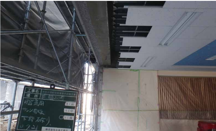
既存校舎改修
