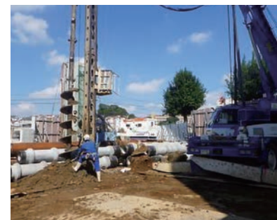
杭打設工事
