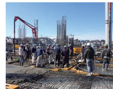
コンクリート打設工事
