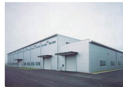
アイダエンジニアリング(株)松任工場第二期工事 (平成8年撮影)
