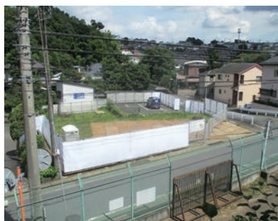
工事着工前のようす
