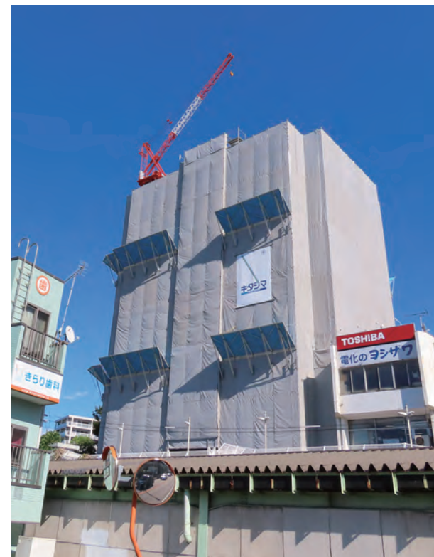
周囲の安全に配慮し、工事が進む
