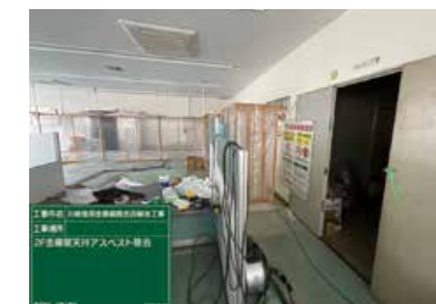
内装材アスベスト除去養生
