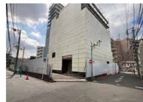
建物周囲養生
