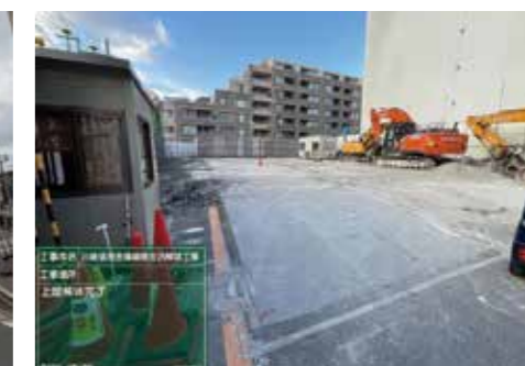
上屋解体完了
