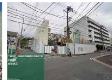
GLからの解体状況
