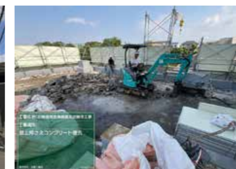
屋上撤去状況
