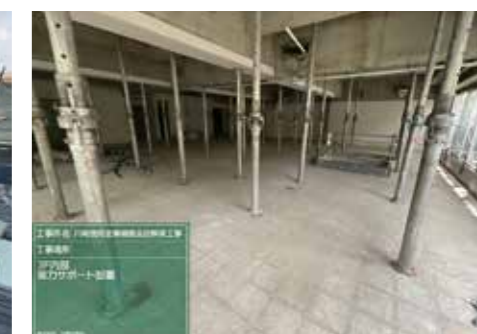
強力サポート設置
