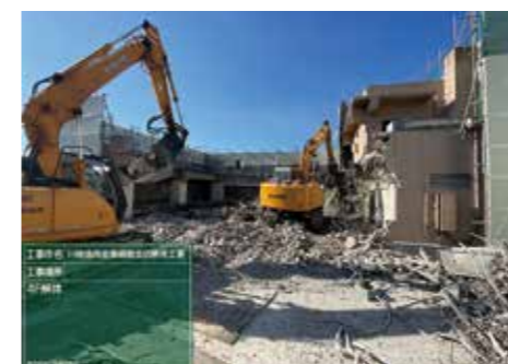
4階躯体解体状況
