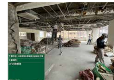
内装解体状況
