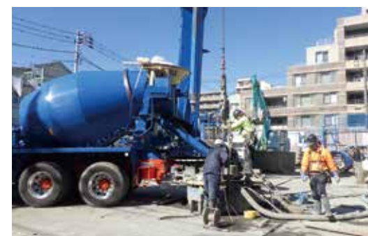
場所打杭コンクリート打設
