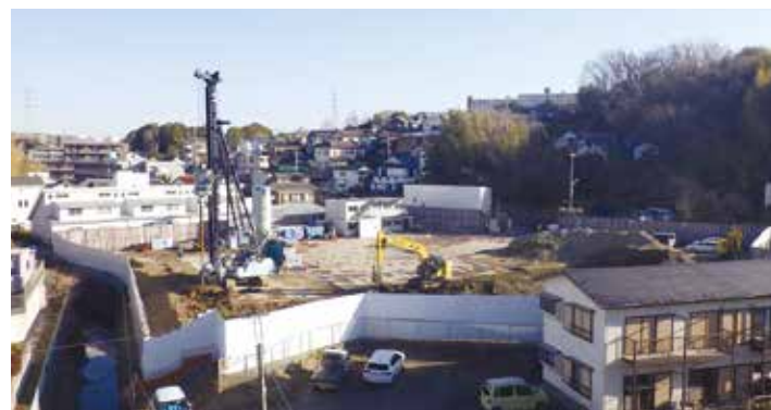
地盤改良工事
