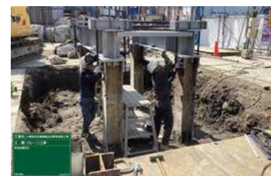
タワークレーン架台設置
