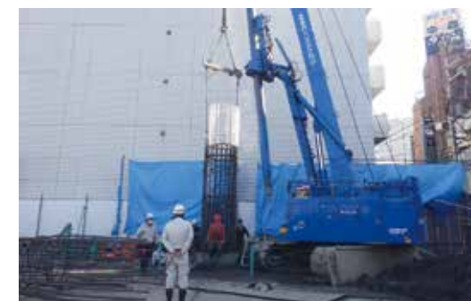
場所打杭鉄筋籠設置
