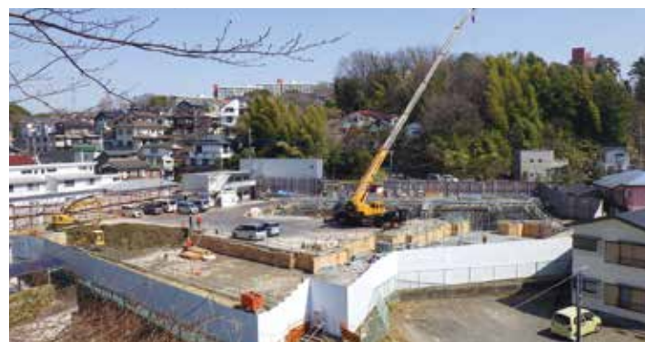
基礎配筋工事
