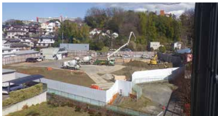
捨てコン打設
