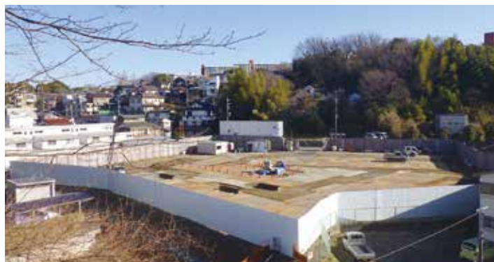
山留親杭打設
