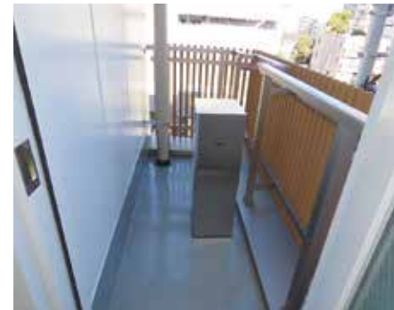
▲バルコニー(緩降機設置)
