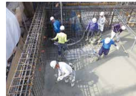
耐圧版コンクリート打設状況
