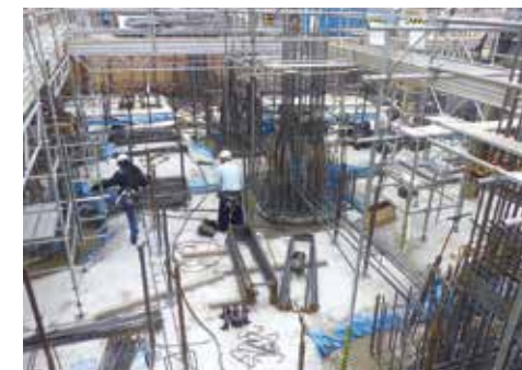
フーチング配筋状況
