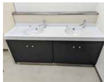
⑤洗面器取付完了
