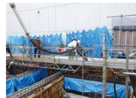
基礎部コンクリート打設状況
