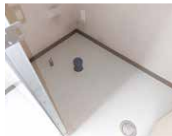
⑤床シート貼替
