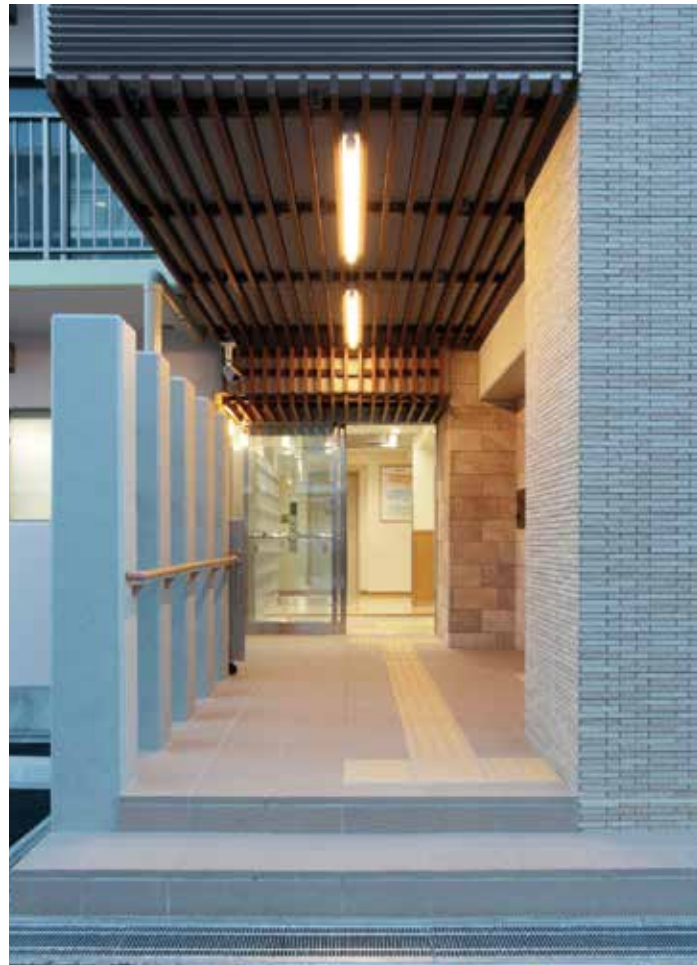
▲エントランス廻り
