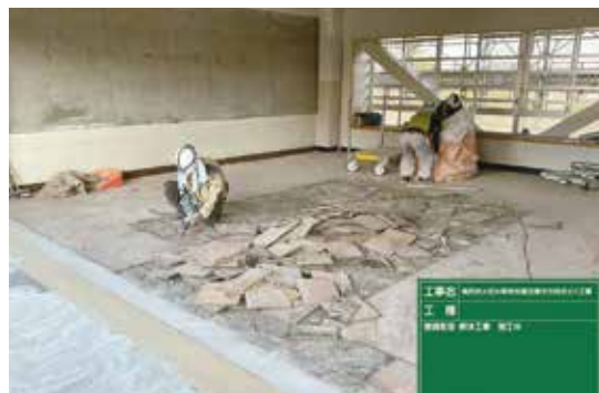
普通教室解体状況
