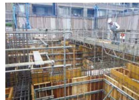
基礎部配筋状況
