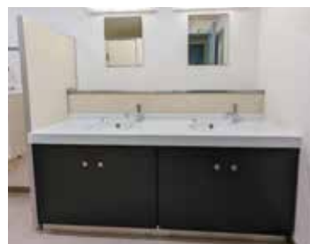
⑥工事完了
