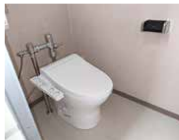
⑥工事完了
