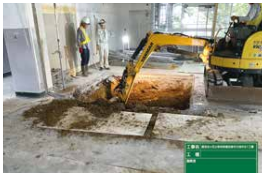
新設昇降機ピット掘削状況
