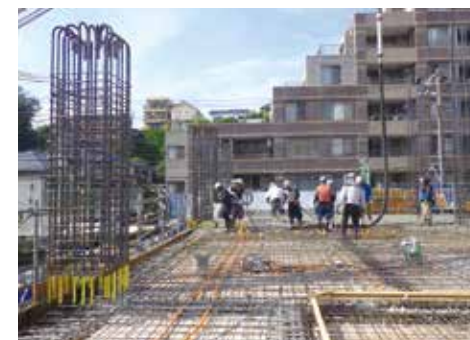
1階コンクリート打設状況
