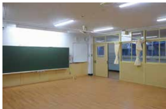
普通教室施工後
