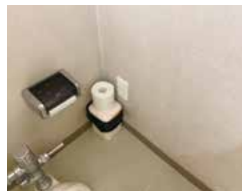
②コンセント新設
