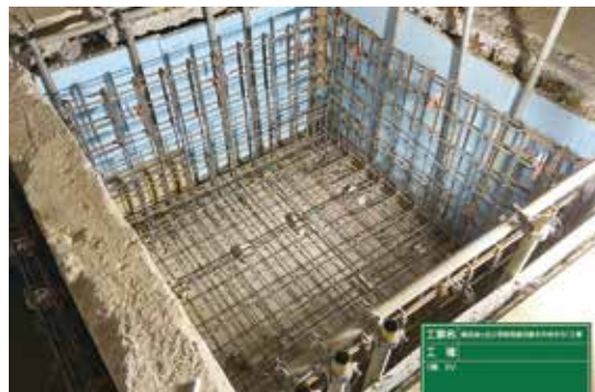
新設昇降機ピット配筋状況
