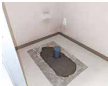
④配管 床モルタル埋
