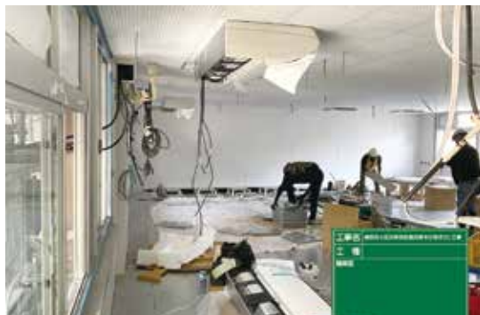
職員室のAフロア施工状況
