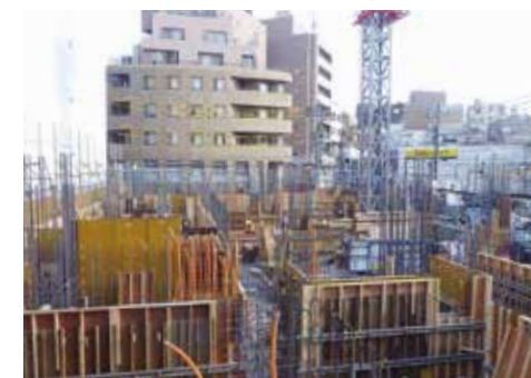
1階立上り配筋状況
