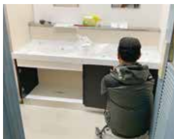
④カウンター一体手洗い器設置
