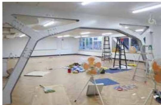
職員室新設耐震ブレース
