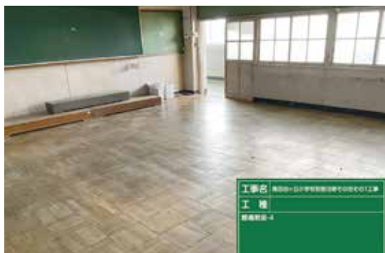
普通教室施工前
