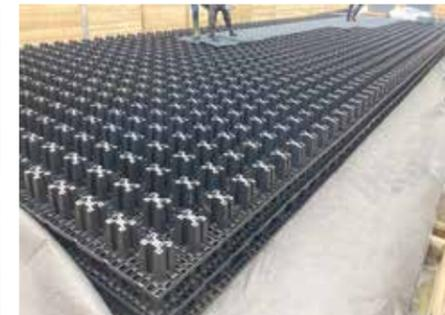
外構 雨水貯留槽クロスウェーブ設置状況
