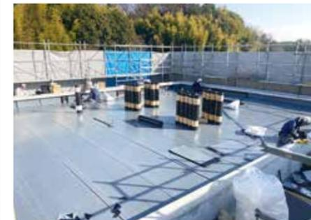
東棟 4階屋根アスファルト防水状況
