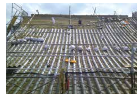
既存瓦屋根撤去状況
