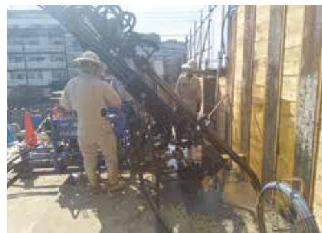
山留アースアンカー打込み状況
