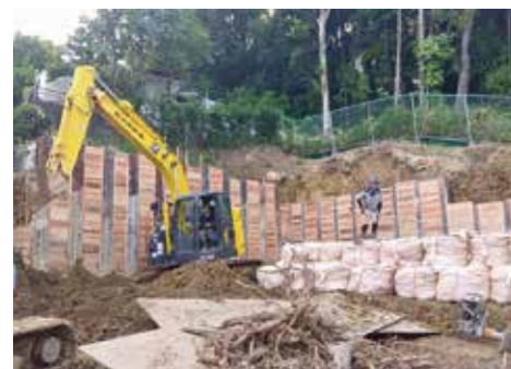
作業床整地状況
