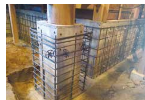
既存基礎補強状況
