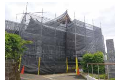
外部足場掛け
