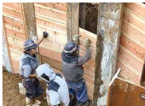
山留矢板入れ状況
