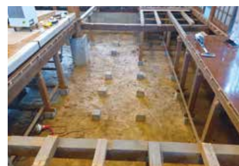
既存床撤去状況
