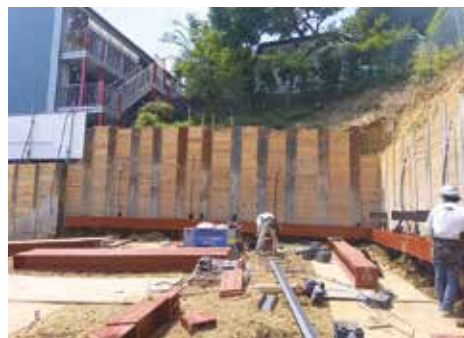
山留腹起し取付け状況
