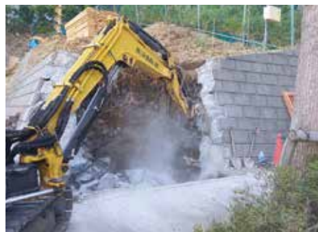
既存擁壁解体状況
