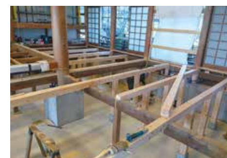
新設床下地組状況
