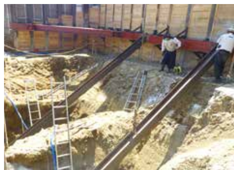
山留斜梁取付け状況
