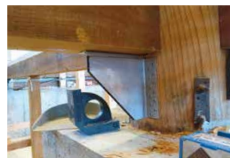
土台耐震金物取付状況
