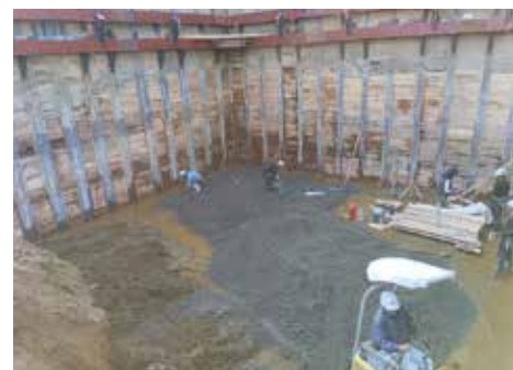
碎石敷き状況
