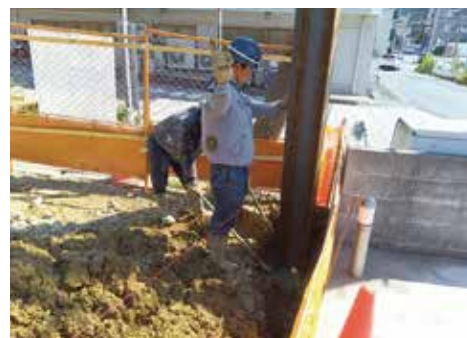
山留親杭打設状況
