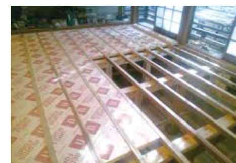
新設床断熱材敷込み状況
