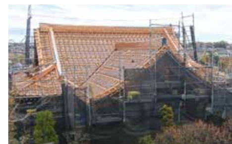
銅板本瓦葺き状況
