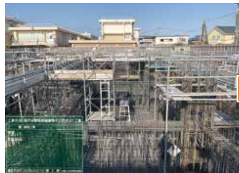
基礎配筋状況
