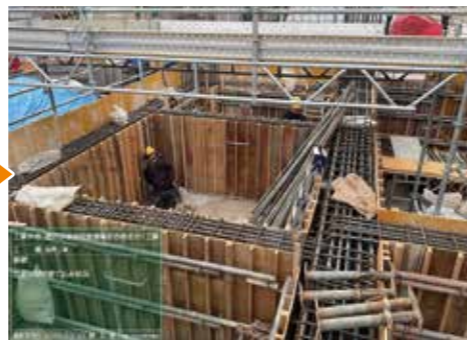
基礎立上り型枠建込状況
