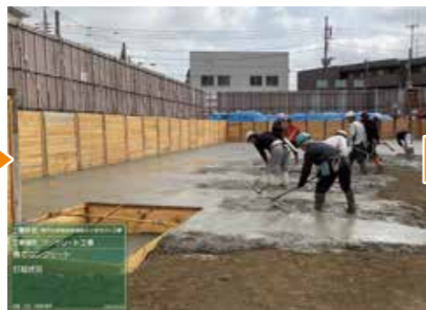
捨てコンクリート打設状況
