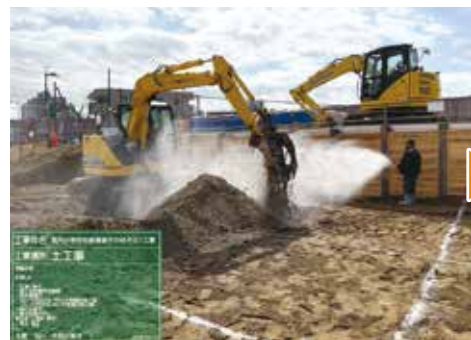
地盤改良攪拌状況
