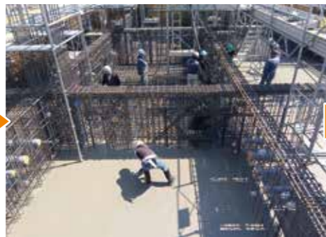
耐圧版コンクリート打設状況
