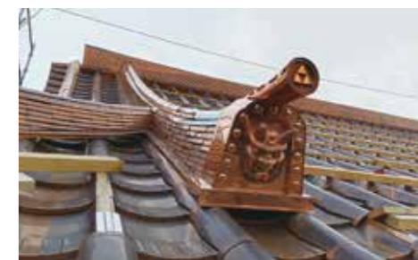
鬼瓦取付状況
