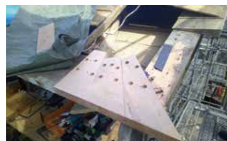
屋根切裏甲交換状況
