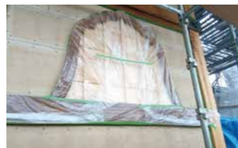
火頭窓取付状況
