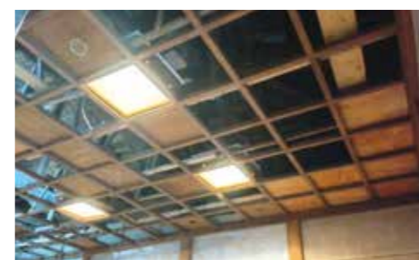
天井鏡板取外し状況
