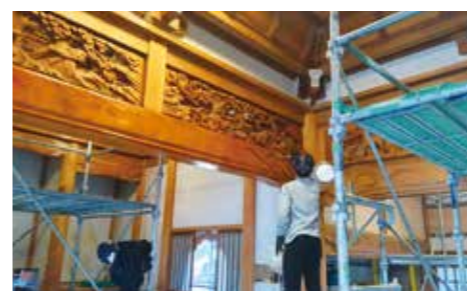
木部灰汁洗い状況
