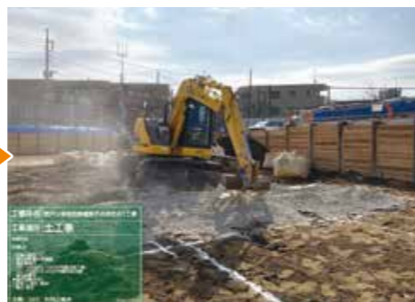
地盤改良固化剤散布状況
