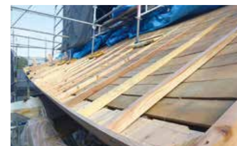
垂木取付状況
