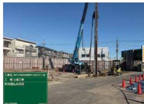
山留親杭建込状況
