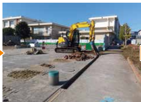
外構解体状況
