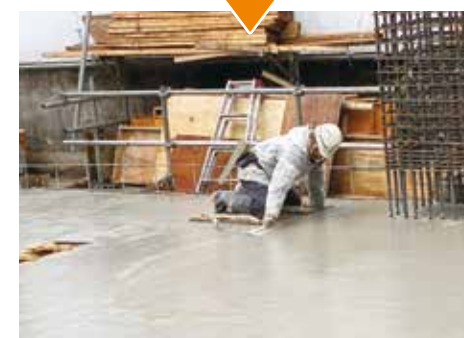
コンクリート押さえ状況
