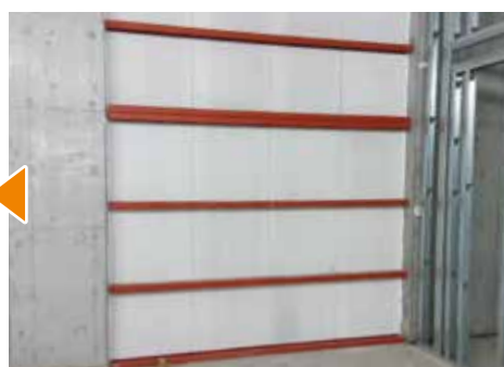
その2工事接続部仮塞ぎ状況
