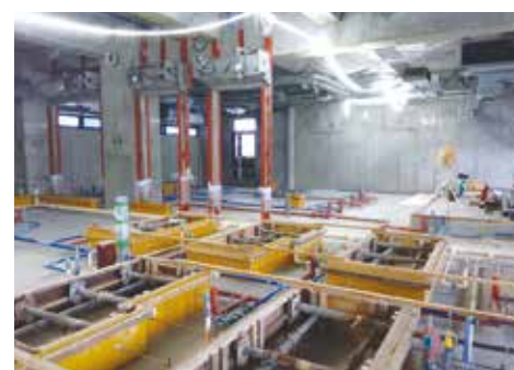
給食室配管状況
