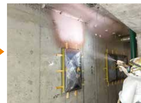
断熱材吹付状況
