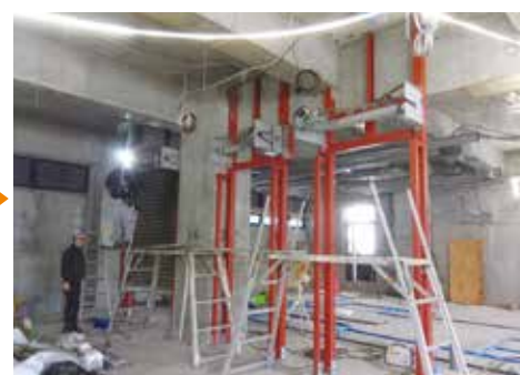
シャッター取付下地鉄骨
