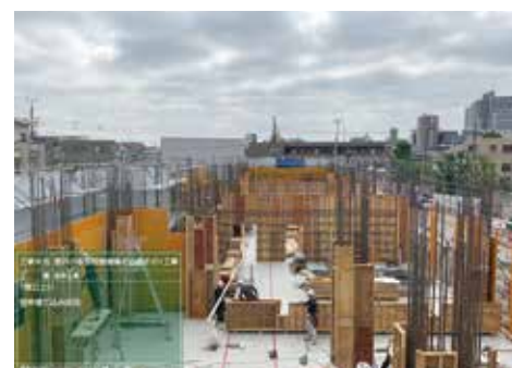
型枠建込状況
