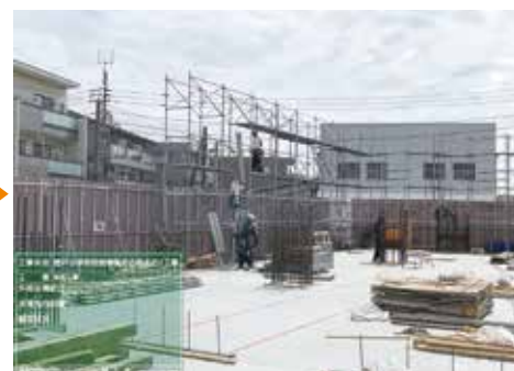
外部足場組立状況
