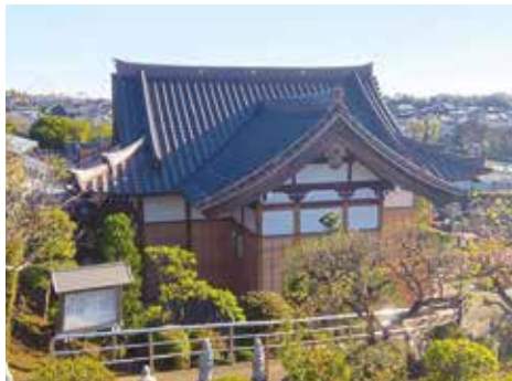
▲外観南面(高台より)
