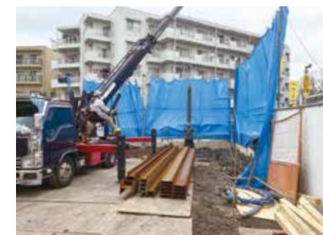
山留打設状況
