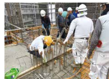
コンクリート打設状況
