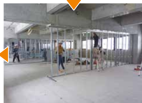
壁LGS取付状況
