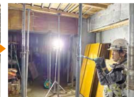
型枠解体状況
