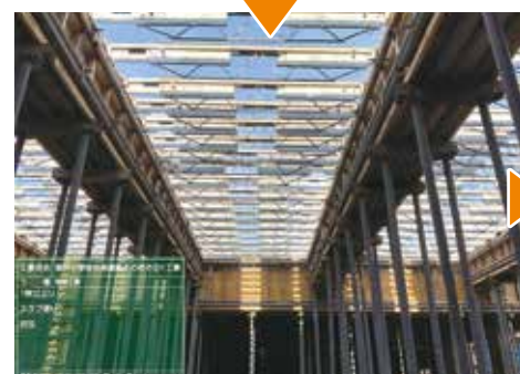
床型枠用ベコビーム設置状況
