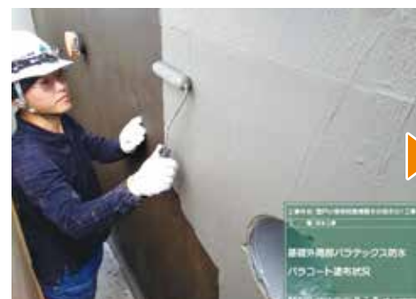
基礎部塗布防水状況
