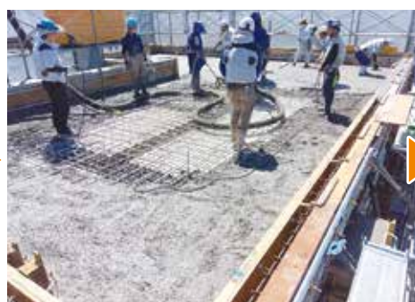
コンクリート打設状況
