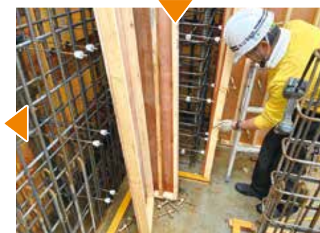
型枠建込状況
